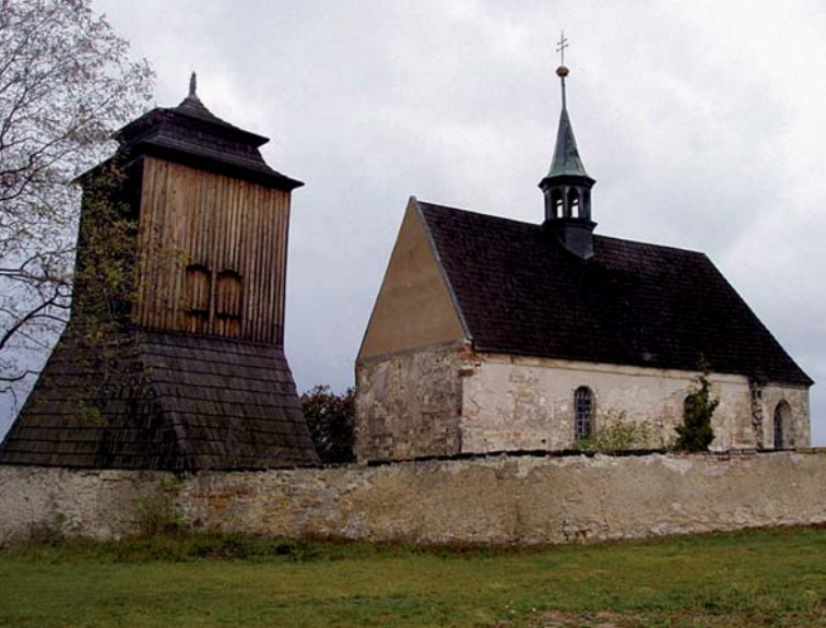
Stav kostela před obnovou a snímky z průběhu obnovy v roce 2013
